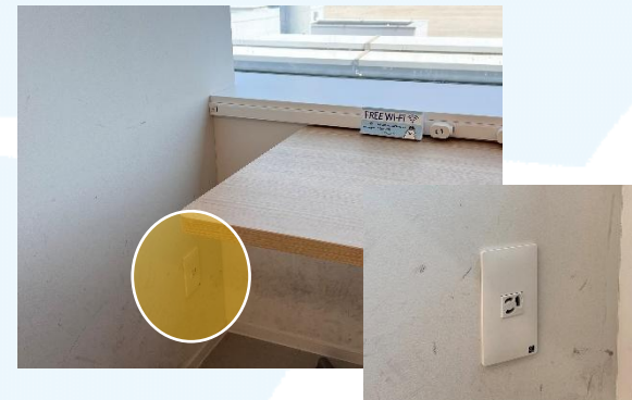
【中央柱側 電源】
